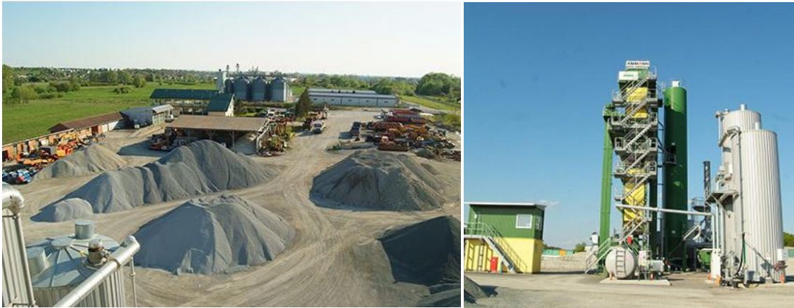
Slika 5. Asfaltna baza i RD za građevni otpad tvrtke Poduzeće za ceste d.o.o. Bjelovar
